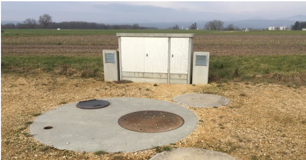
Abbildung 51: Foto einer typischen fertig ausgebauten Produktionsbohrung. An der Oberfläche sind nur eine Betonplatte mit zwei Schachtdeckeln, zwei Betonfundamentplatten für die Abstützung des Bohrgeräts und ein Elektrokasten zu erkennen.
