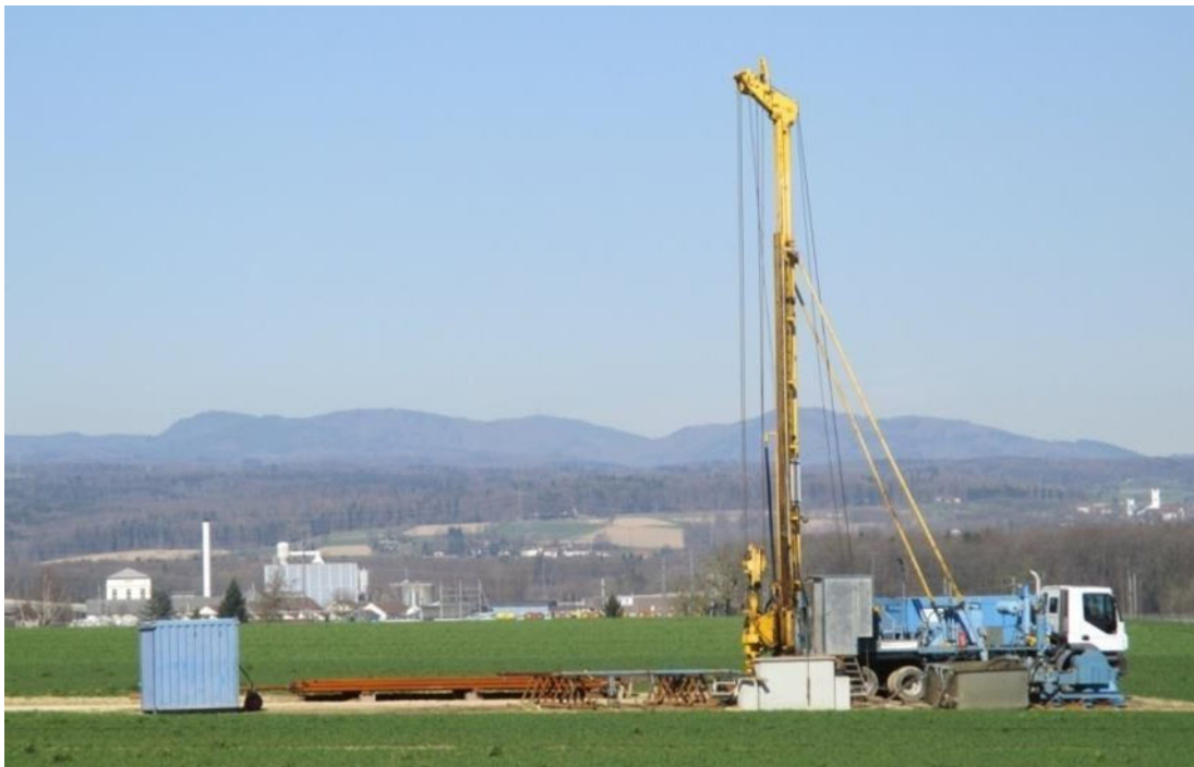
Abbildung 46: Foto eines Bohrplatzes im Gebiet der Saline «Riburg» während der Bauphase einer Produktionsbohrung der Schweizer Salinen AG.
